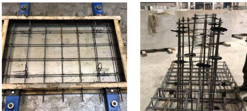
Рис. 5. Вязка стержней и крепление защитных фиксаторов
