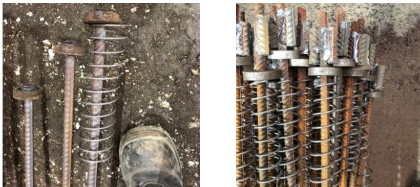
Рис. 4. Временные концевые анкера
