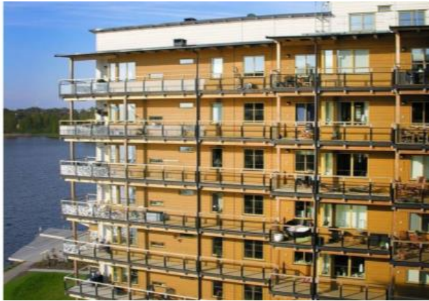
Рис. 1. Многоэтажное здание из CLT-панелей
