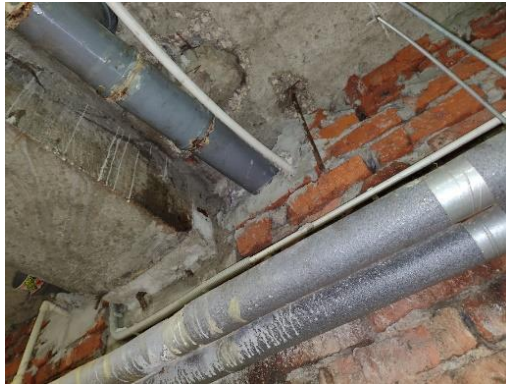
Рис. 2. Течь канализации
